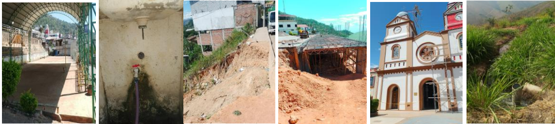
5 de septiembre 2025. Verificación del estado de la cancha de vóley, de la calle Dolores Campoverde, de la fachada de la iglesia matriz, del estado de aguas servidas en Buenavista
