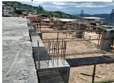
21 de agosto 2025. Verificación de avances en la construcción de la Cancha sintética del Centro Buen vivir
