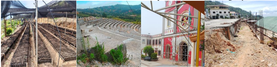
23 de julio 2025 Verificación de estado del vivero y de la reconstrucción e la fachada de la iglesia.
