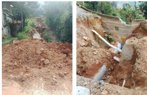
29 de mayo 2025. Verificación de trabajos de remediación de la calle 5 de Junio
