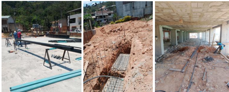
7 de octubre 2025. Verificación de avance de trabajos en el centro del Buen Vivir
